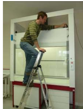
Dépose du panneau frontal et inspection visuelle (câbles, roulettes,...)
